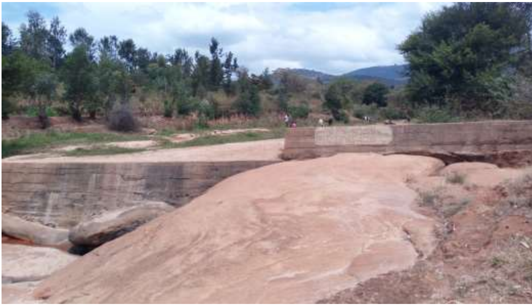
Plate 7-6: Kwa Veleki Sand Dam
