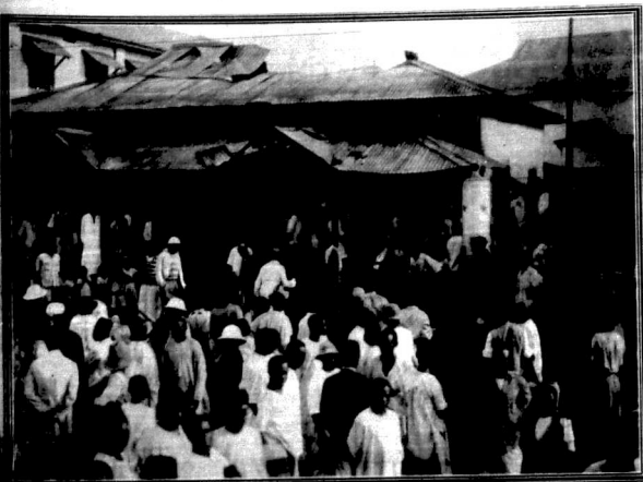
THE RECENT FIRE at Kampala. Photo: A. H. Waeffe & Co. Kampala.
