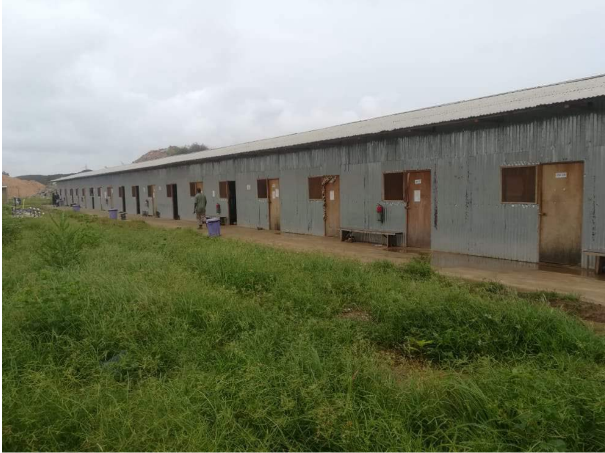
Dortoir des travailleurs de l'entreprise avant leur démantèlement sur injonction de l'inspecteur du travail.
